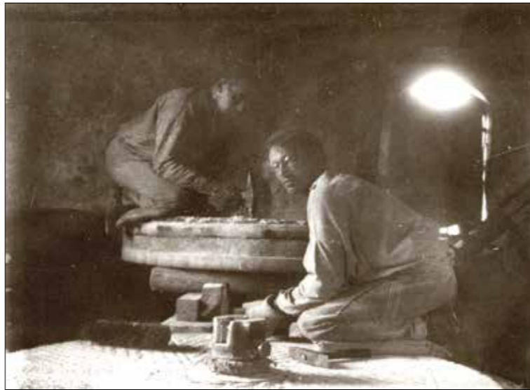
Niek Treurniet en zijn knecht zijn de molenstenen aan het billen. Tijdens deze arbeidsintensieve klus scherpten ze met hamer en beitel de groeven in de maalstenen.
