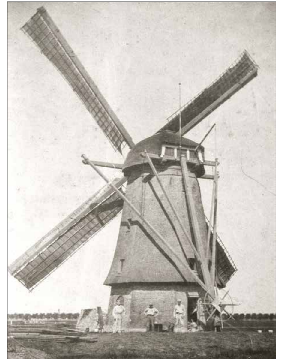
Vermoedelijk is deze foto gemaakt in 1906 tijdens de bouw van de schuur om een 16 pk motor te plaatsen. De motor dreef een koppel maalstenen aan wanneer er niet voldoende wind was om de molen te laten werken. Hier zien we Nicolaas tussen twee van zijn zonen
