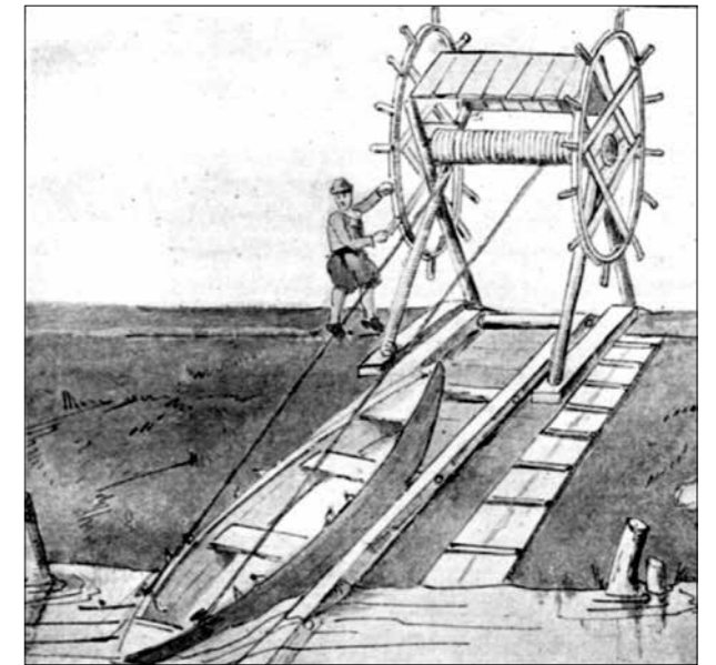
Een scheepje wordt met behulp van een overtoom met windas over de dijk getrokken
