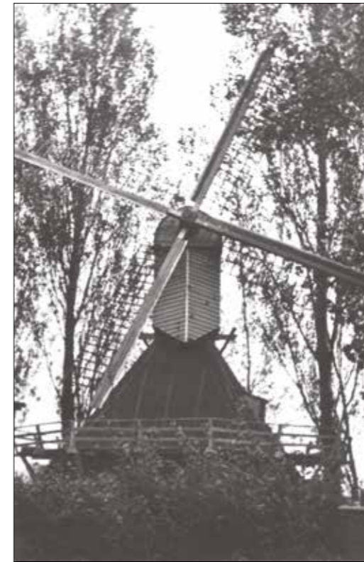
Wipstellingmolen "De Berkel" was een kleine industriemolen waar Theo de Groot olie mee perste
