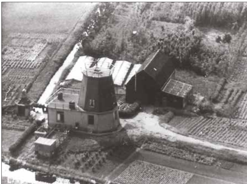
Luchtfoto van de geknotte korenmolen met het aangebouwde woonhuis en de oude schuren. Links van het woonhuis staat de kleine wipstellingmolen genaamd "De Berkel"
